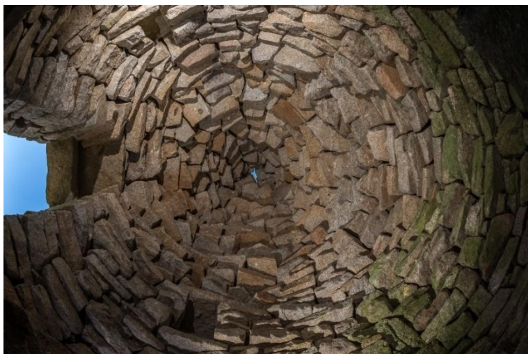
Particolare dell'interno dei caprili
